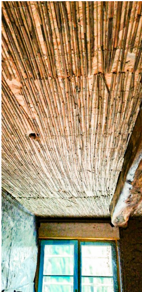
Schilfrohr auf OSB-Dampfbremse
